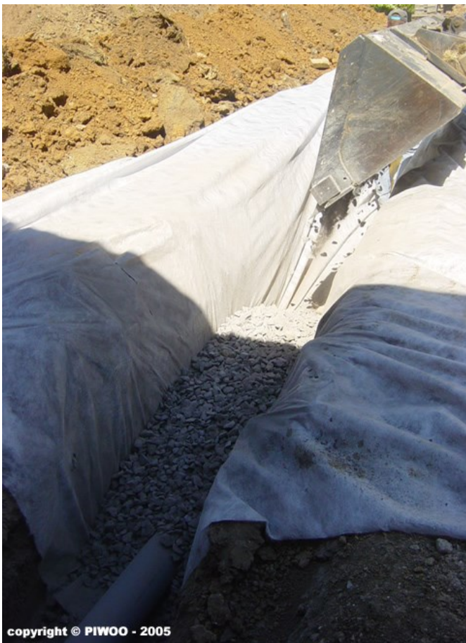
Tranchée d'infiltration en gravas non traités
