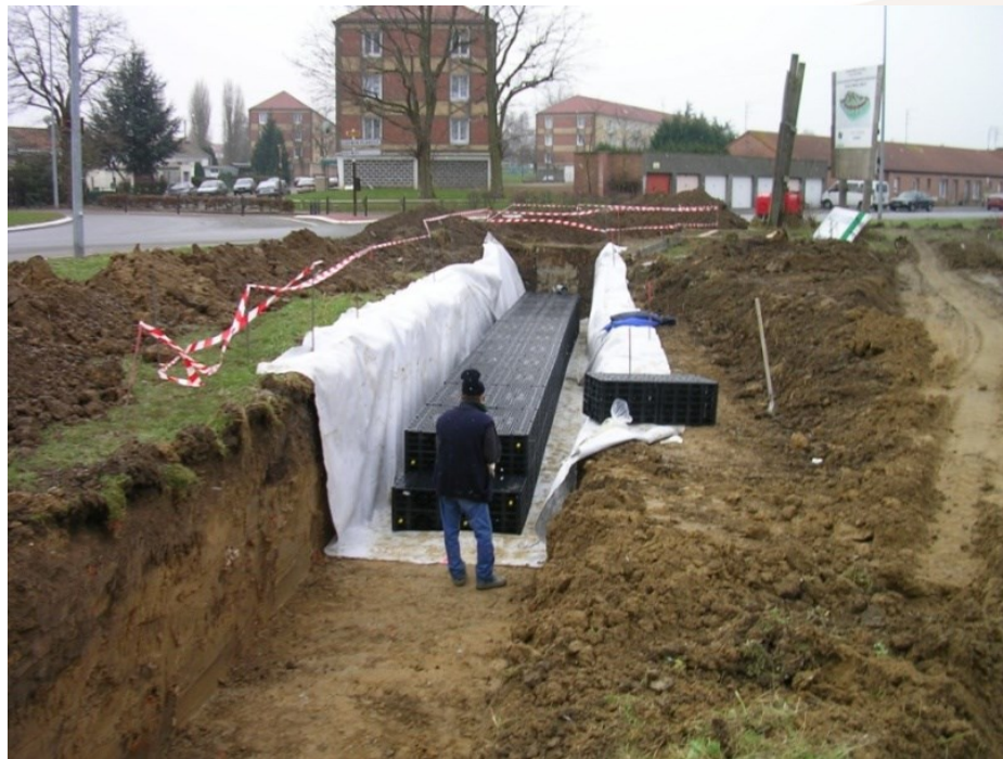
Tranchée d'infiltration en SAUL
